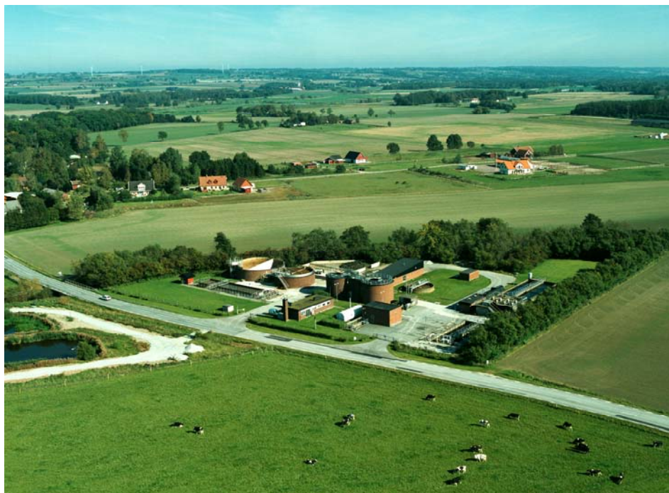
Figur 2. Flygfoto över anläggningen och dess närmaste bebyggelse i nordostlig riktning
